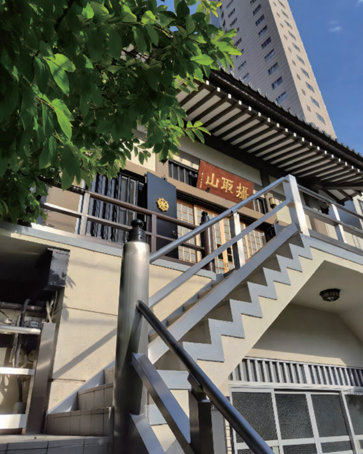
北階段タイルと高欄ステンレス工事
